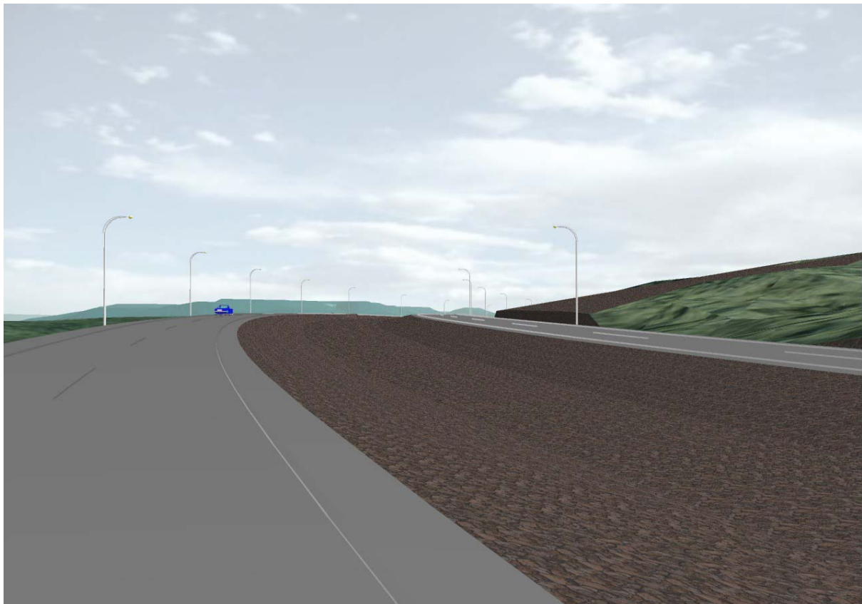
Mynd 20b Eftir breikkun Reykjnesbrautar. Séð frá akbraut, horft í austur að hraunkanti í Afstapahrauni. Í forgrunni núverandi akbraut og miðdeilir, nýja akbrautin fjær, þá skeringar í hraunkantinum.
